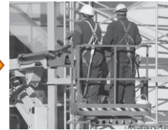
MONTAJE & PUESTA EN MARCHA
